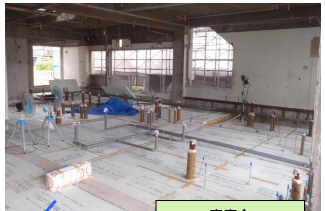
寄宿舍 (厨房床下配管工事)
