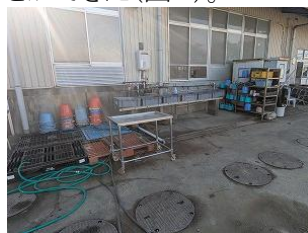
図 5 整備した洗い場
