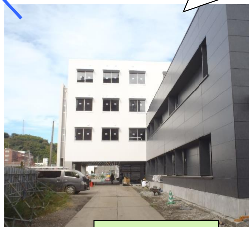
敷地内南西側
