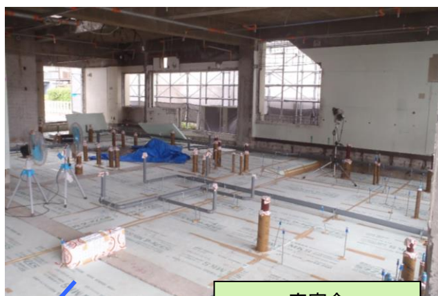
寄宿舍 (厨房床下配管工事)
