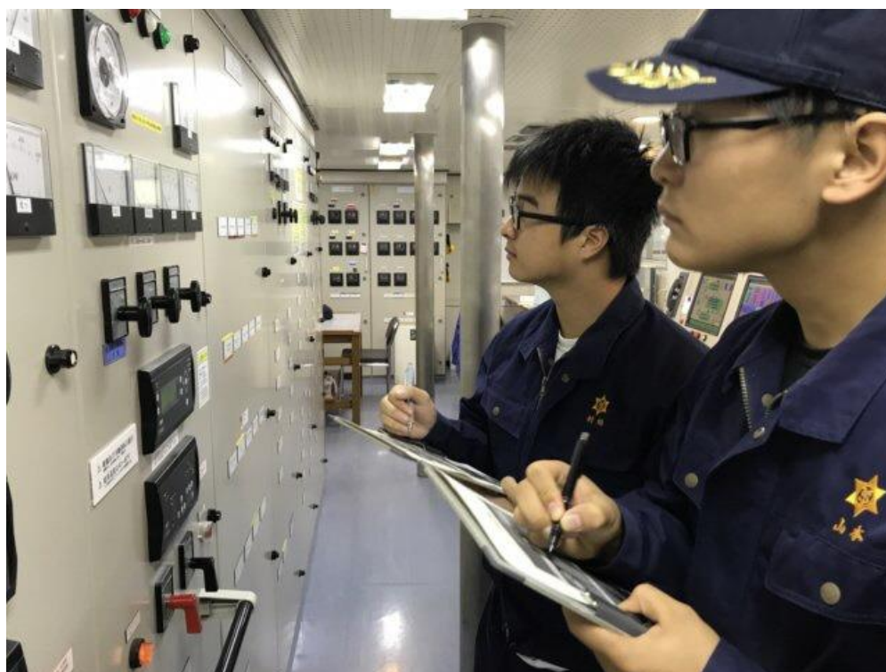
専攻科機関の生徒は配電盤チェック
