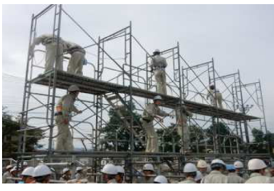
体育祭応援席と「アーチ」の設営のための足場組み立て。これらは全て生徒自らが行います。
