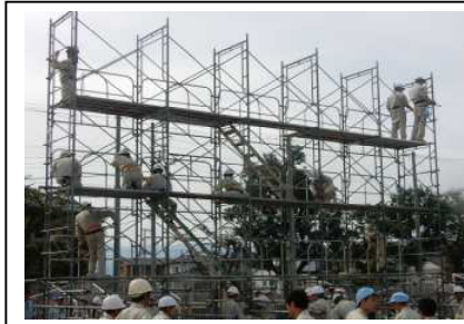
「アーチ」設営のための足場は4段にも達する高さです。
