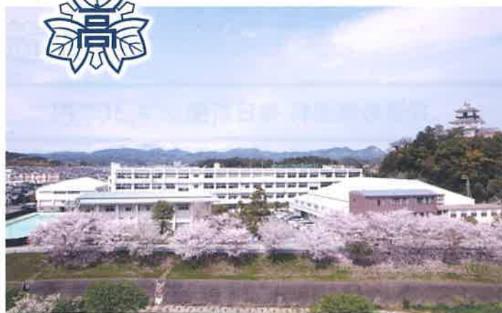
掛川西高の校舎
